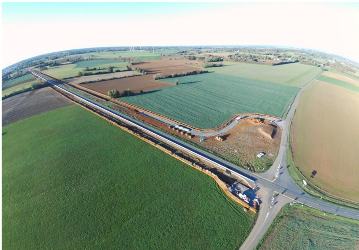
Vue d'ensemble des travaux (même disposition que le plan de situation). A droite au carrefour dit des « 4 routes » création d'un giratoire, en direction de Clussais sur la gauche terrain où sera créé un bassin de récupération des eaux de pluie. Direction Melle sur la droite on aperçoit l'ébauche de la voie parallèle.
